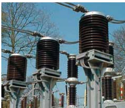
➤ Трансформатор тока 72,5 кВ (CX). Yuandon Textil Co. (Тайвань).
