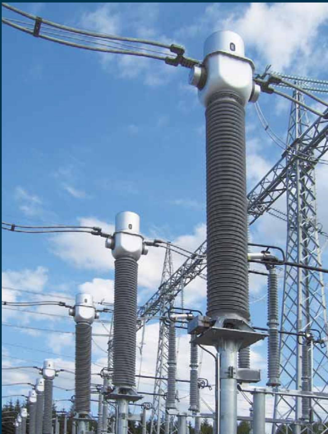
› Трансформаторы тока 420 кВ с изолятором из силиконового каучука серого цвета. Statnett (Норвегия).
