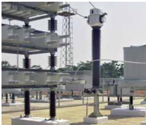
2. Трансформаторы тока 245 кВ с защитой блока конденсаторов (Индия).
